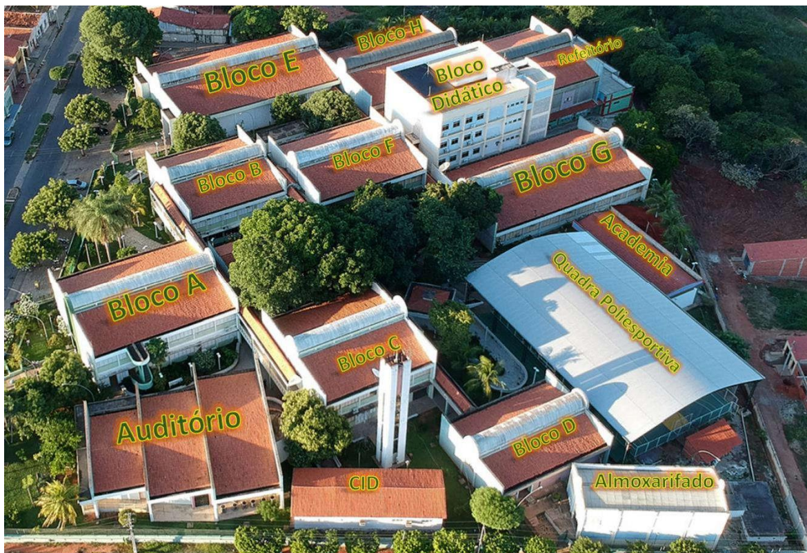
Figura X - Vista aérea do campus Cedro situado na Alameda José Quintino
