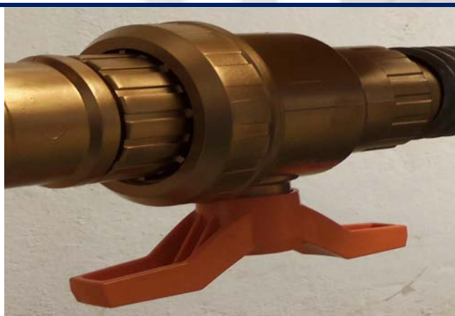
Registro de controle de esgotamento do canal.
