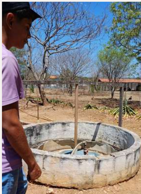
Figura 8 – Biodigestor para produção de energia e biofertilizante
