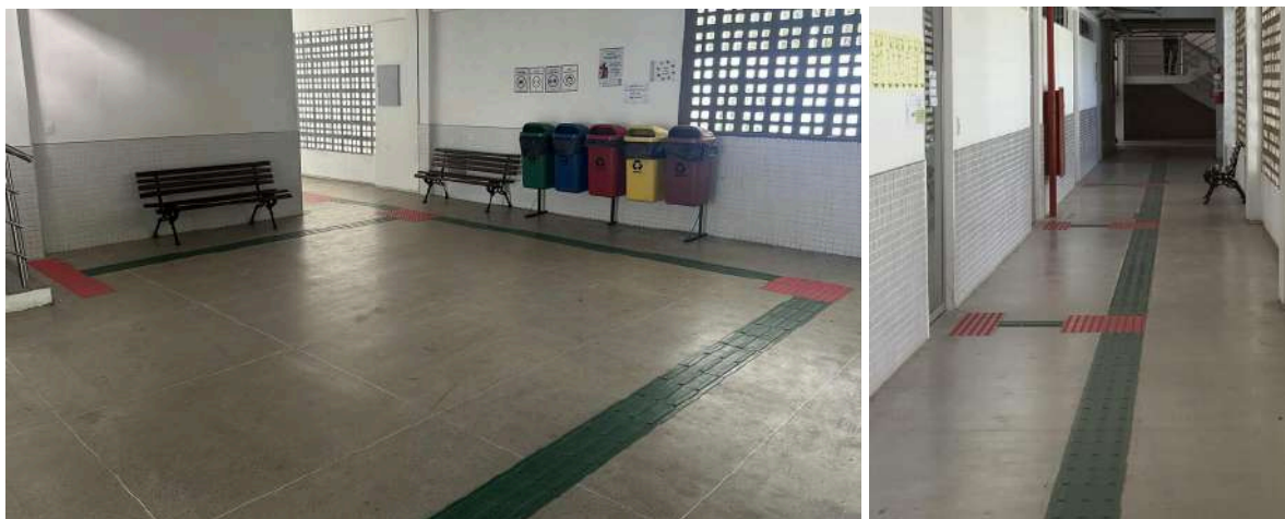
Figura 13 - Piso tátil no campus Horizonte.
