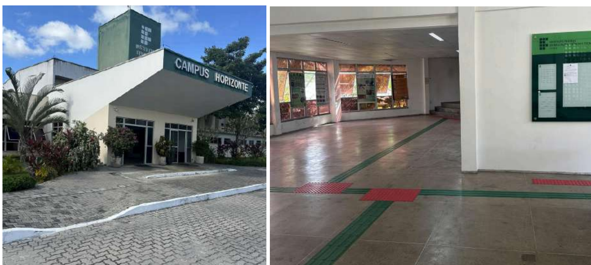
Figura 12 - Rebaixamento das calçadas e piso tátil no campus Horizonte.
