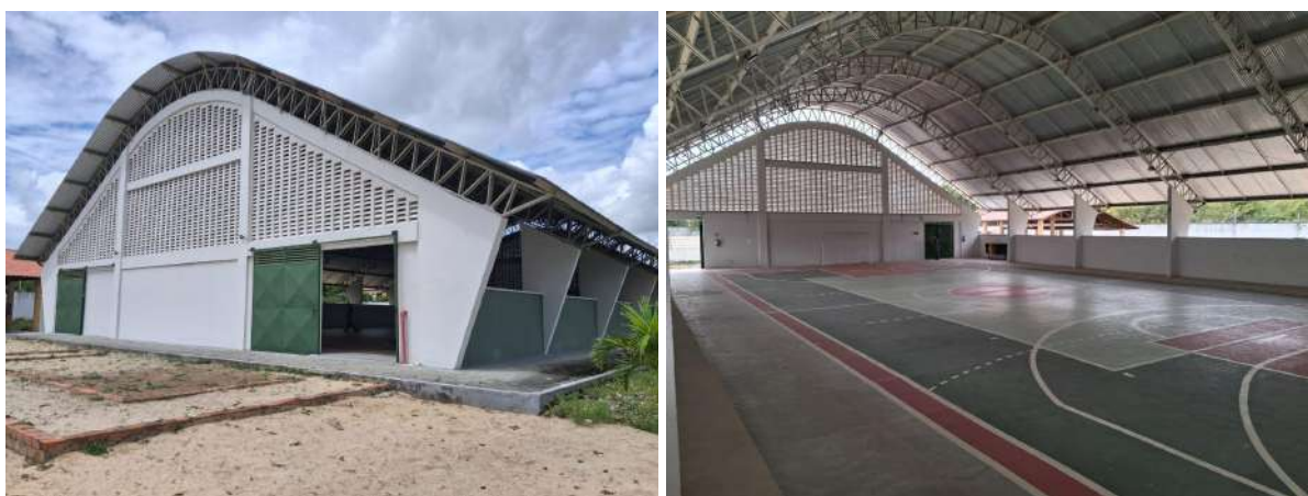
Figura 5 - Quadra Poliesportiva do IFCE campus Horizonte.
