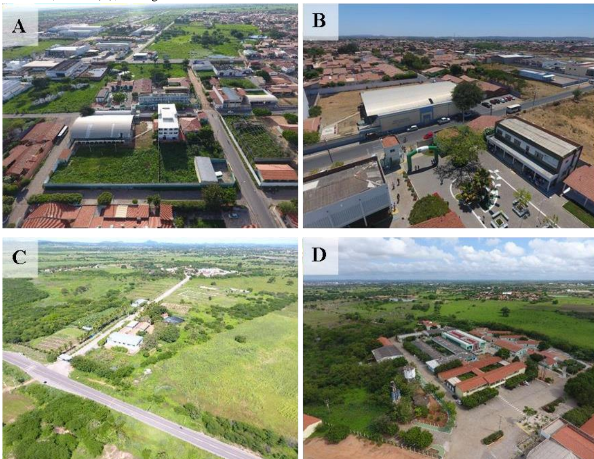
Figura 2 - Visões gerais das infraestruturas das unidades Areias (Unidade I) e Cajazeiras (Unidade II) do campus Iguatu do IFCE: visão geral da unidade I, Areias (A); detalhes do pavilhão pedagógico e da quadra de esportes da unidade I, Areias (B); visão geral.
