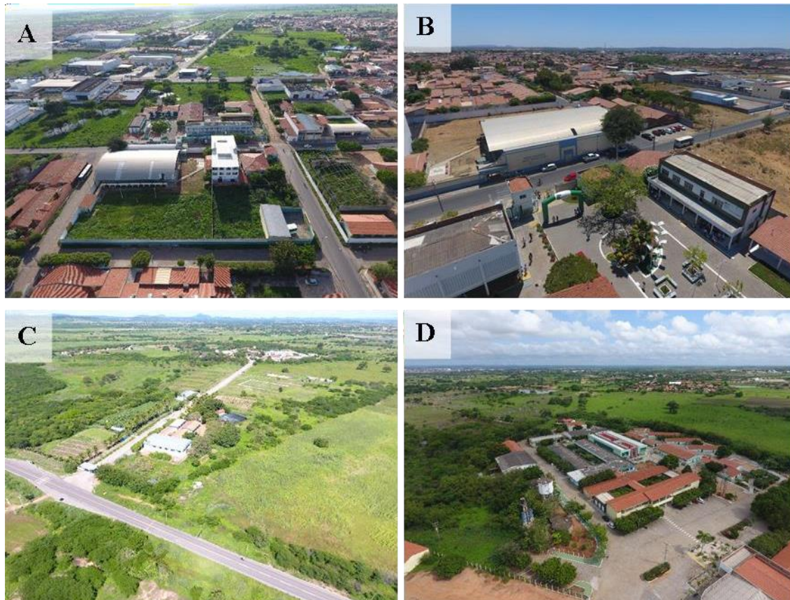
Figura 2. Visões gerais das infraestruturas físicas das unidades Areias (Unidade I) e Cajazeiras (Unidade II) do campus Iguatu do IFCE: visão geral da unidade I, Areias (A); detalhes do pavilhão pedagógico e da quadra de esportes da unidade I, Areias (B); visão geral da unidade II, Cajazeiras (C); detalhes dos pavilhões pedagógicos e administrativos da unidade II, Cajazeiras (B).
