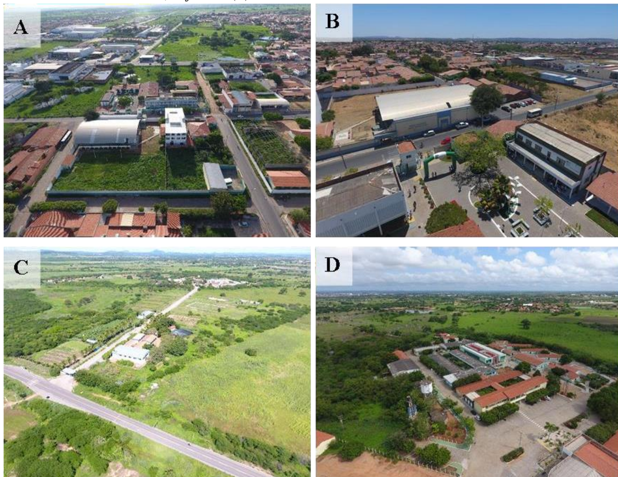
Figura 2 Visões gerais das infraestruturas das unidades Areias (Unidade I) e Cajazeiras (Unidade II) do campus Iguatu do IFCE: visão geral da unidade I, Areias (A); detalhes do pavilhão pedagógico e da quadra de esportes da unidade I, Areias (B); visão geral da unidade II, Cajazeiras (C); detalhes dos pavilhões pedagógicos e administrativos da unidade II, Cajazeiras (B).
