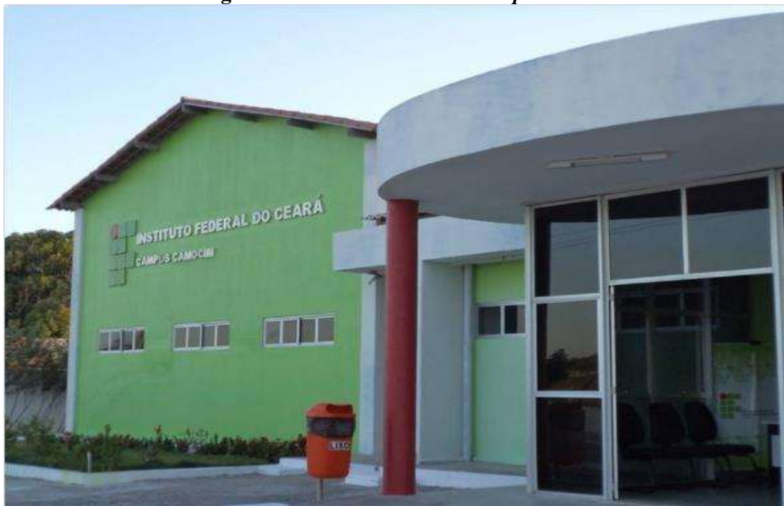
Figura 2: Fachada do IFCE-Campus Camocim
